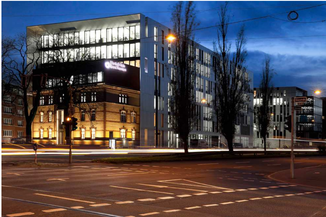
Clara und Robert in Düsseldorf: Der Neubau von Slapa Oberholz Pszczulny Architekten umschließt mit auskragender Fassade schützend das historische Saarhaus. Foto © ADO Lights by TTC Timmler Technology GmbH / Fotograf Peter von Pigage
