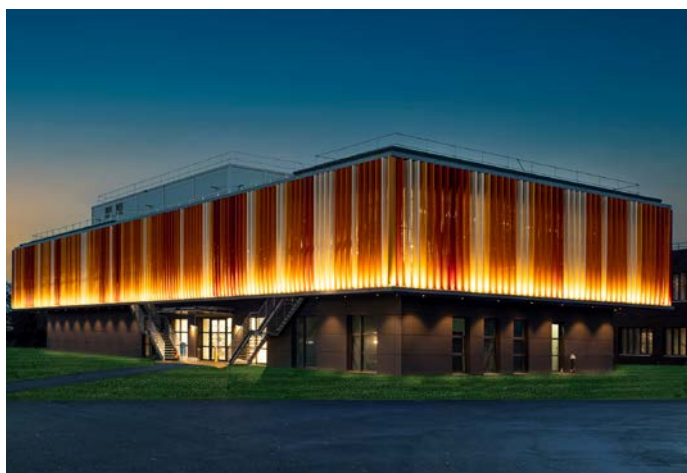
Abb.: Verschiedenfarbige vorgehängte Lamellen dienen als Sonnenschutz. Bei Einbruch der Dunkelheit, wird die Fassade in farbiges Licht getaucht.
