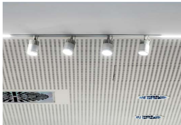
Abb.: Die Spots »LED-Luc 60-1« sind mit einem Kugelmagnetgelenk ausgestattet und schwenk- und drehbar. Die Farbtemperatur beträgt 4.000 K.
